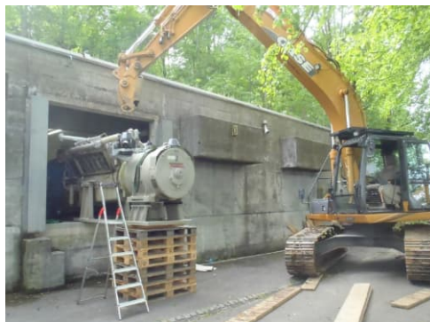
Ausbau von 2 SLM-12YD14 aus einer ehemaligen Lenkmaschinenstellung
